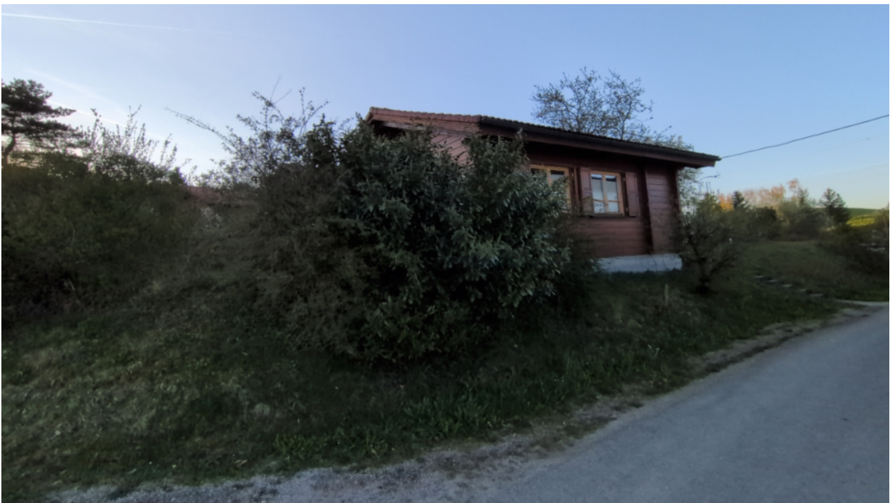
Abb. 8: Entfallende Holzhütte mit angrenzender Böschung, Blick aus nordwestlicher Richtung
