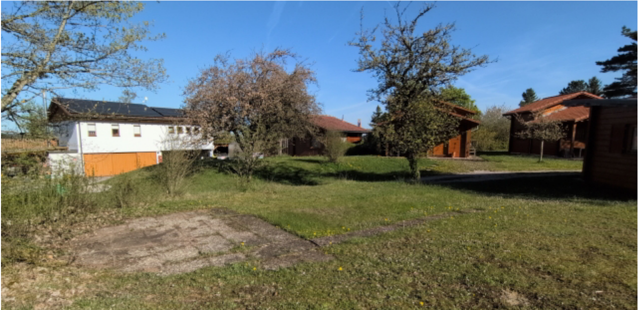
Abb. 4: Sicht auf einen überplanten Wohnmobilstellplatz mit Bestandsgebäuden im Hintergrund, Blick aus südöstlicher Richtung
