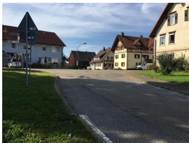
Abb. 25: Baubeginn Dietersweiler innerorts
