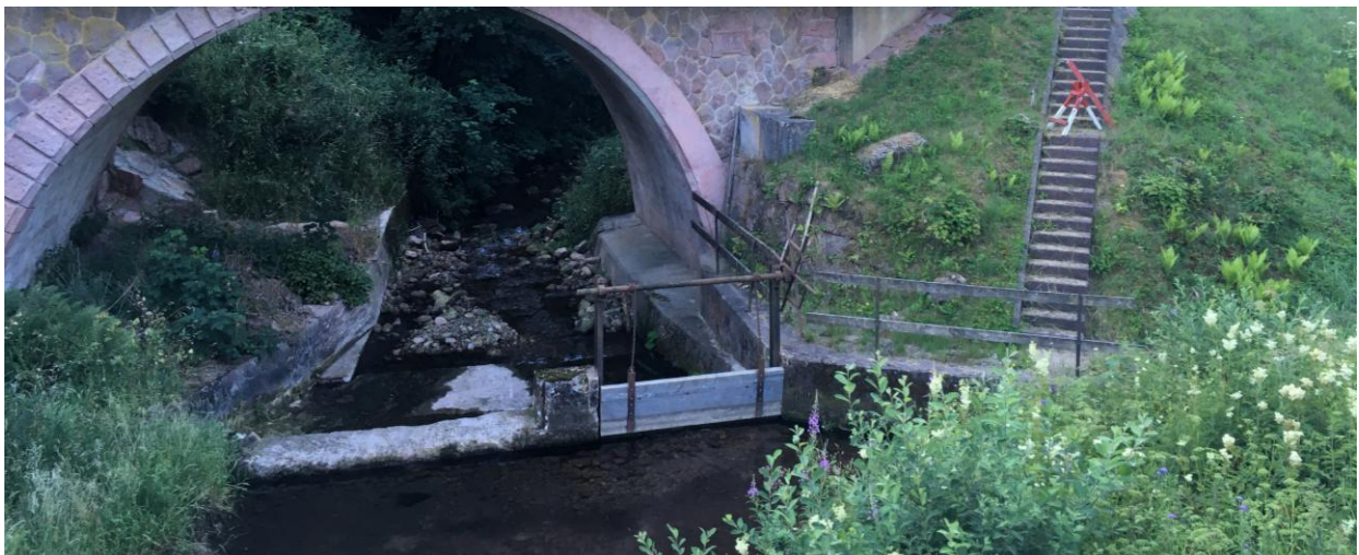
Abb. 43: Lage Betonschwelle / Bauwerk
