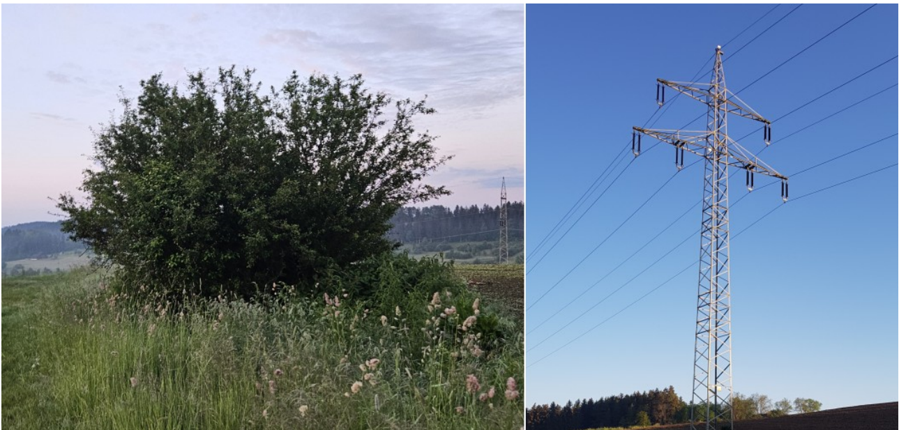
Abb. 6: Schlehegebüsch und Freileitungsmast im Plangebiet
