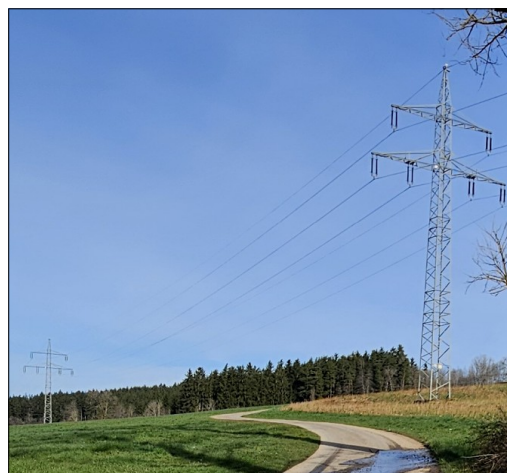
Abb. 1.6-6 Hochspannungsmast im Südwesten des Plangebiets auf Ackerflächen.
